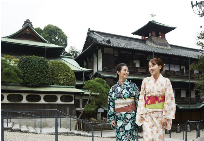
道後温泉本館 保存修復の間も入浴できます。
